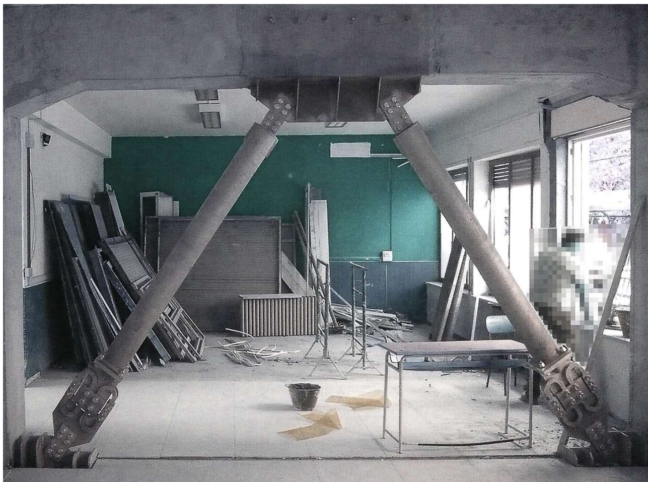
Installazione di controventi dissipativi
