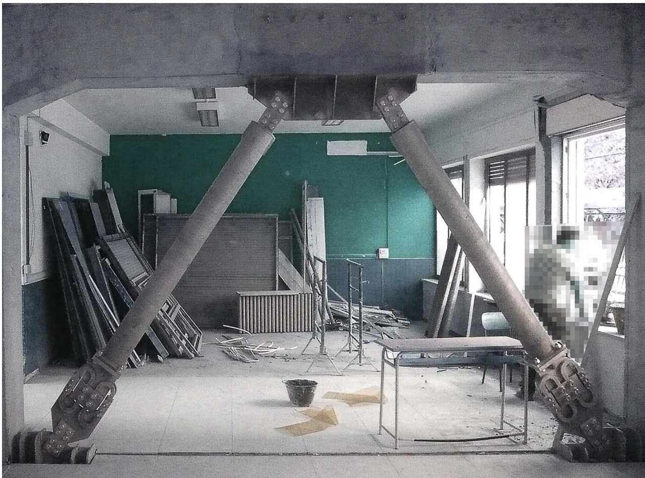
Installazione di controventi dissipativi
