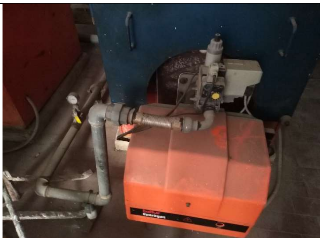
Particolare bruciatore a gas
