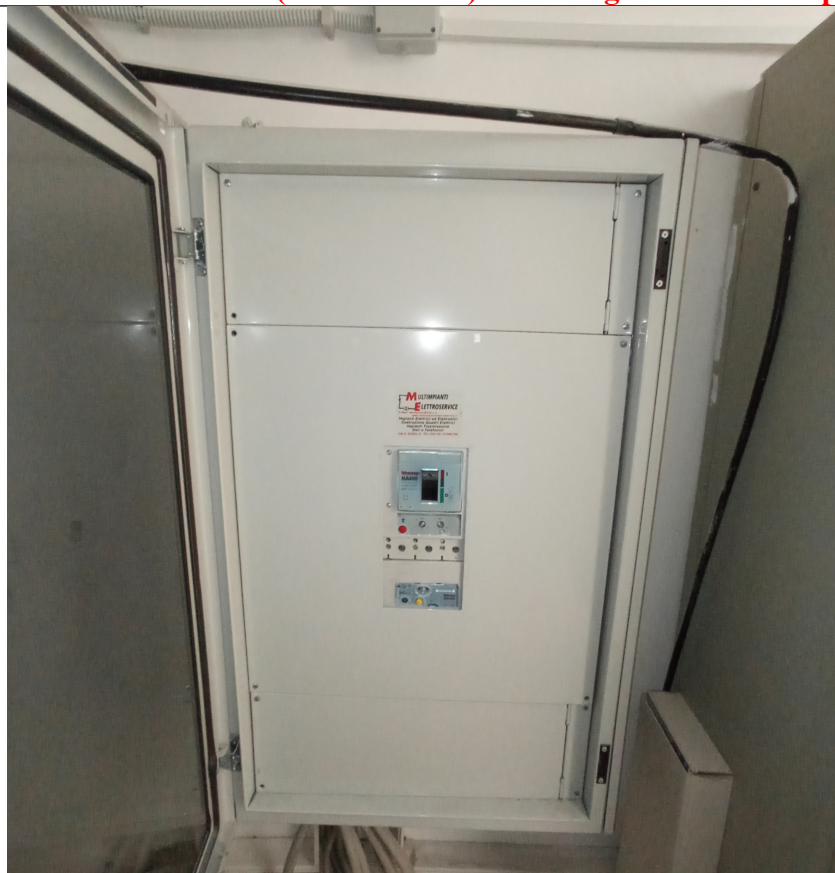
Foto 14: Interruttore magnetotermico + modulo differenziale (locale quadri)
