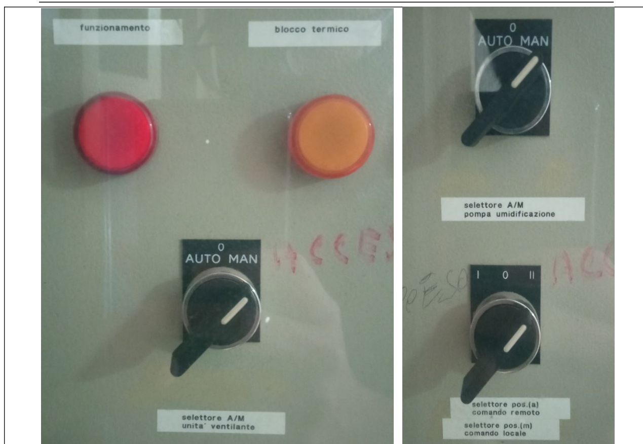
Foto 9: Ingrandimento quadro comandi condizionamento centralizzato
