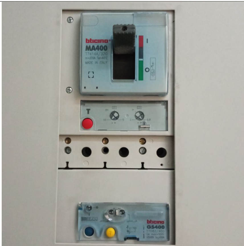
Foto 15: Ingrandimento interruttore magnetotermico + modulo differenziale
