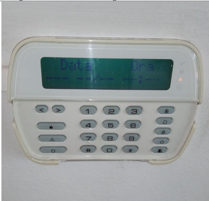
Foto 16: Centralina allarme (hall di ingresso)
