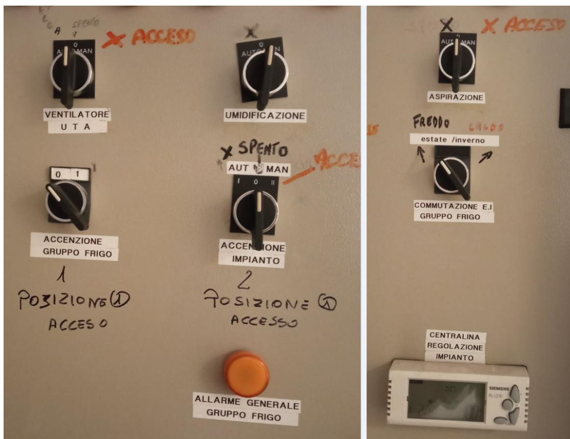
Foto 9: Ingrandimento quadro comandi condizionamento centralizzato
