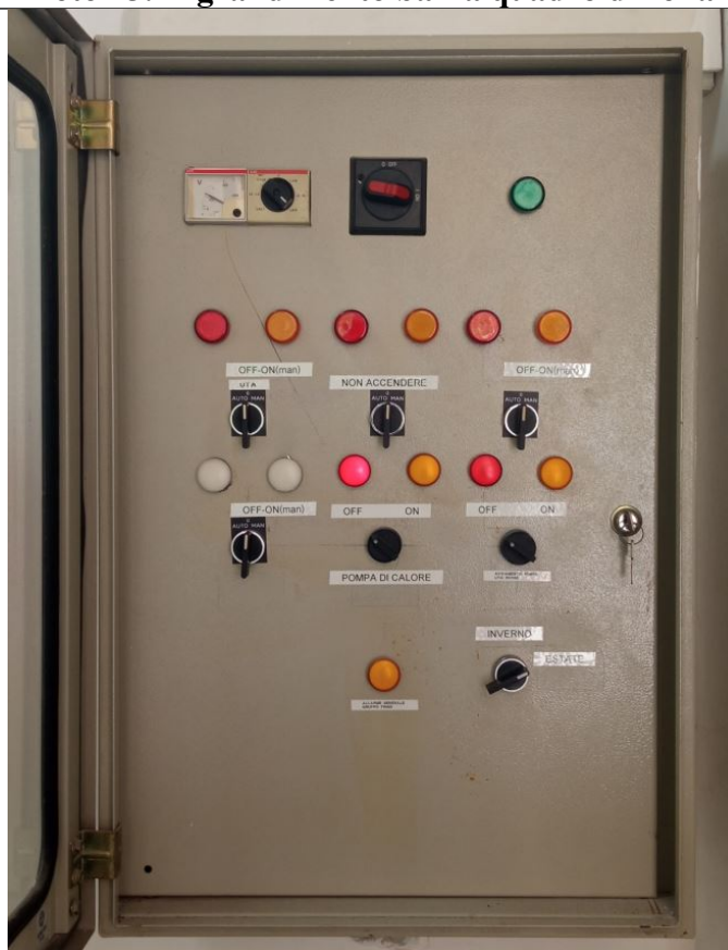
Foto 26: Quadro comandi condizionamento centralizzato (corridoio B)
