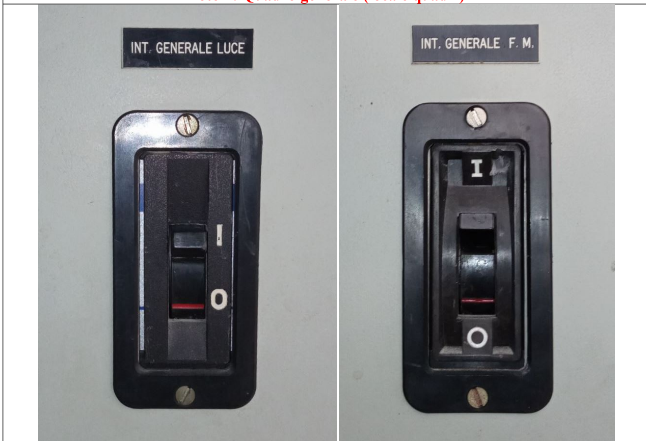
Foto 2: Ingrandimento interruttori generali del quadro generale
