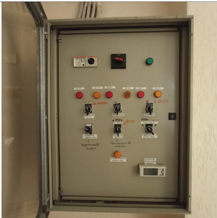
Foto 7: Quadro comandi condizionamento centralizzato (corridoio laterale)
