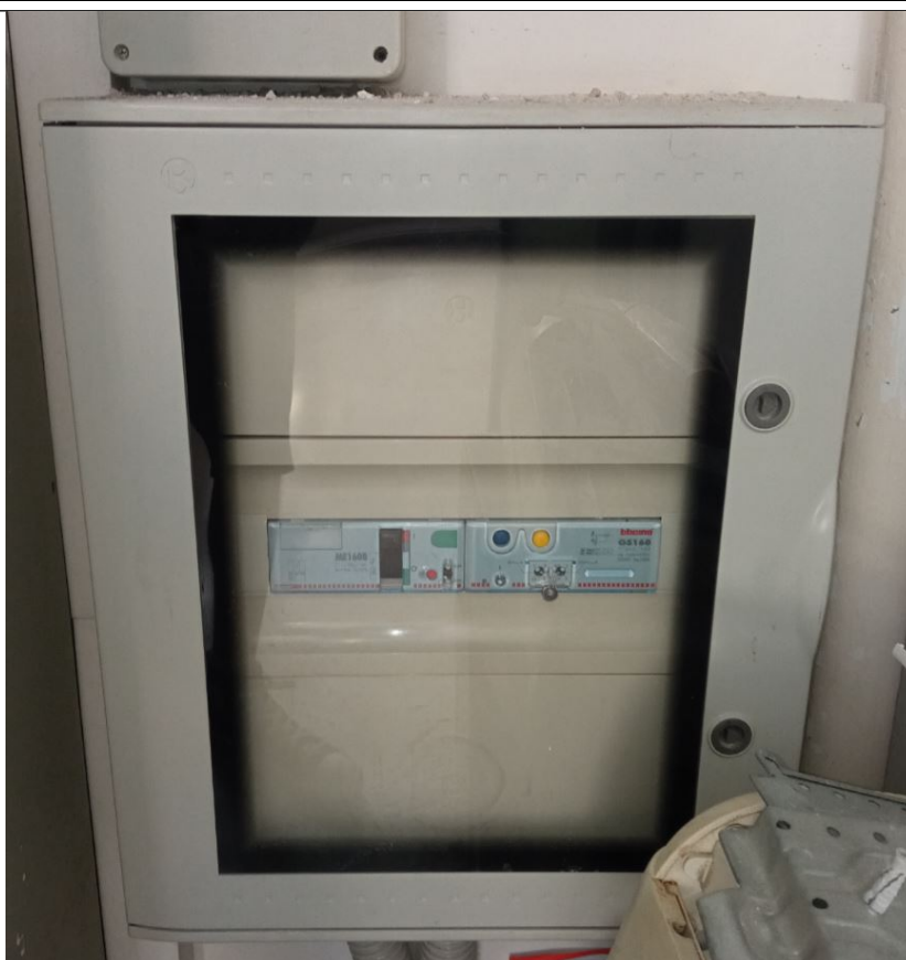
Foto 7: Interruttore magnetotermico + modulo differenziale (locale quadri)
