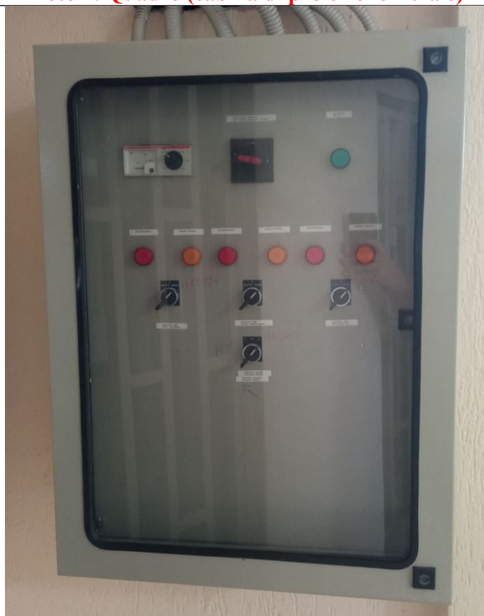
Foto 8: Quadro comandi condizionamento centralizzato (corridoio uff.direttore)
