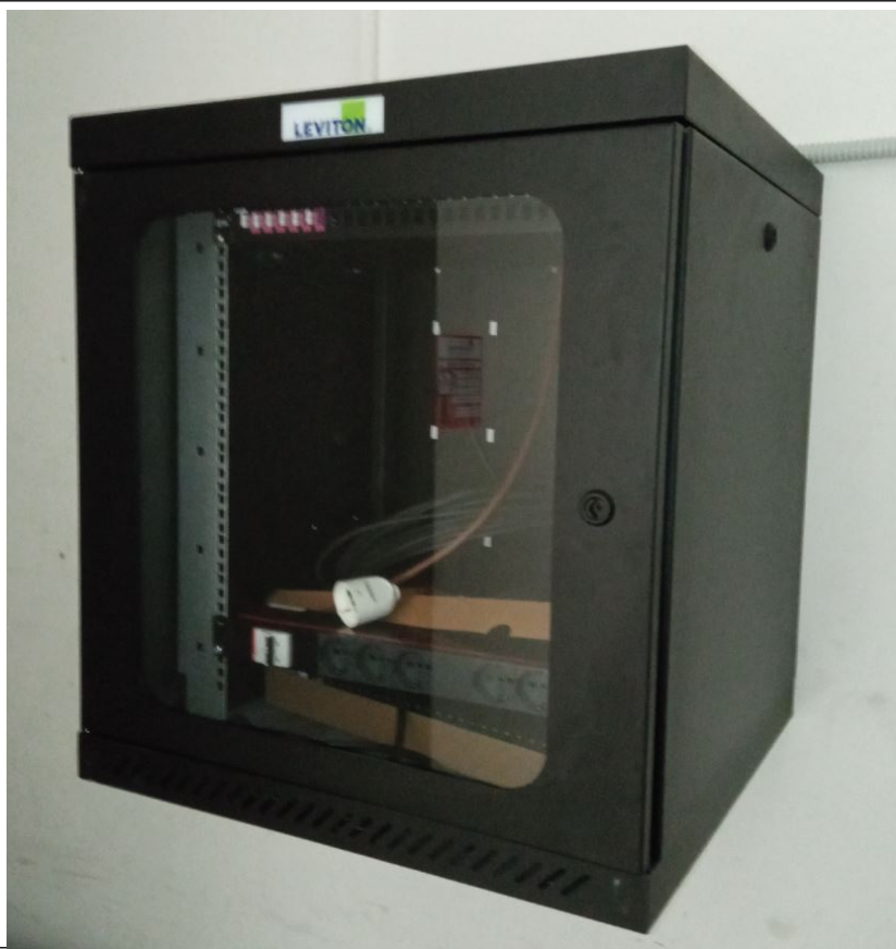
Foto 13: Armadio rack dati (locale tecnico) – da integrare con Rack portineria
