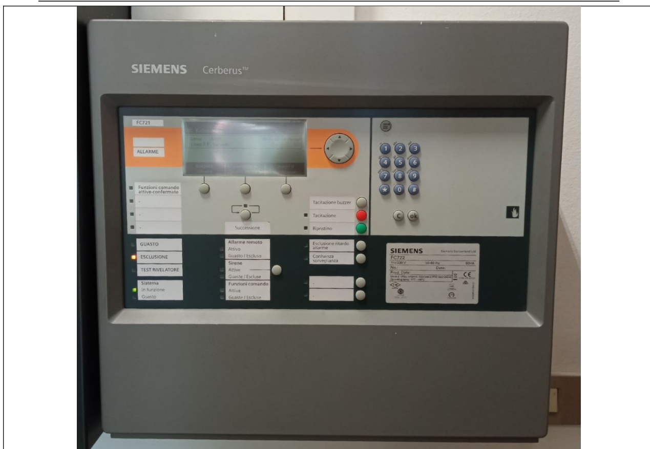
Foto 17: Centrale rivelazione incendio (portineria)
