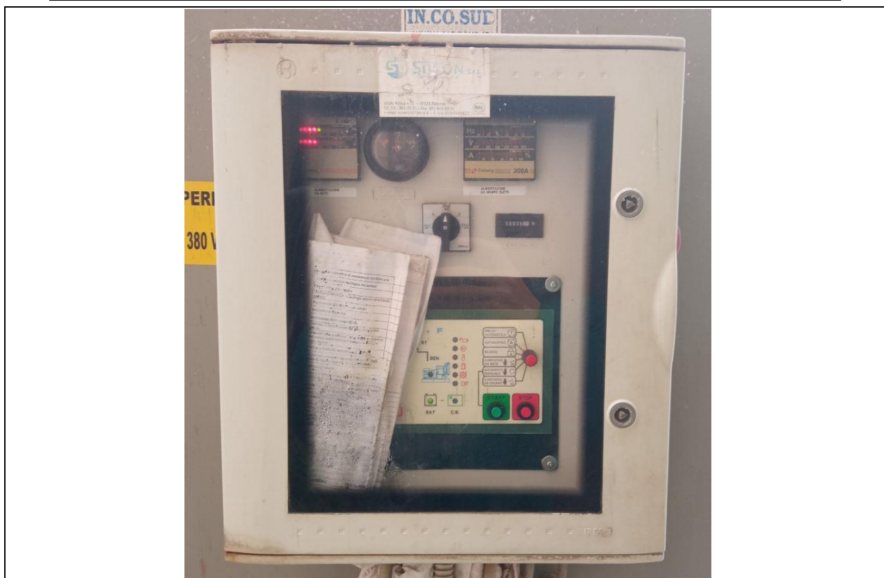
Foto 11: Quadro gruppo elettrogeno (piano terra)
