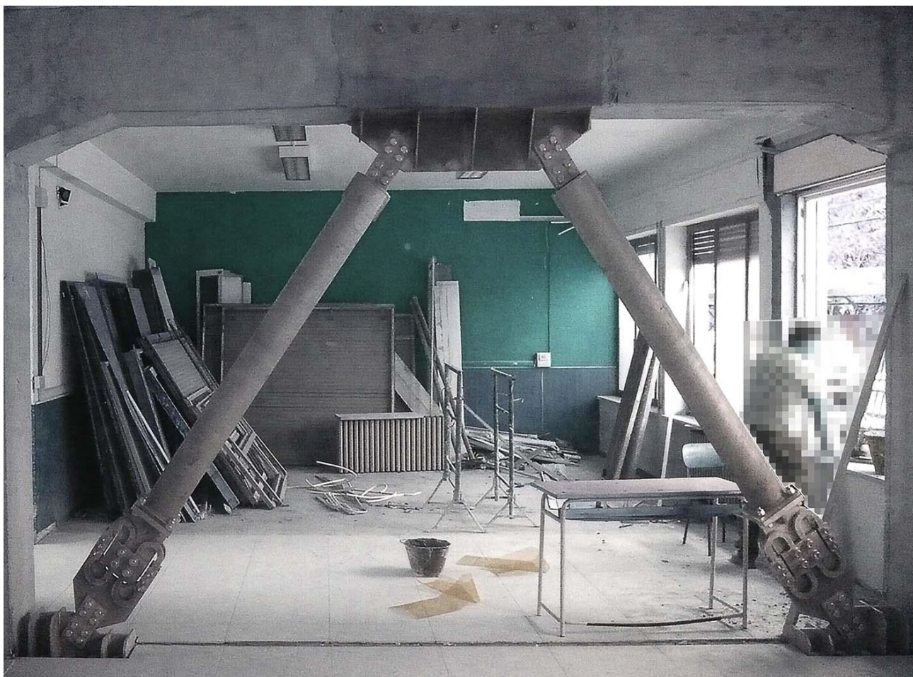
Installazione di controventi dissipativi
