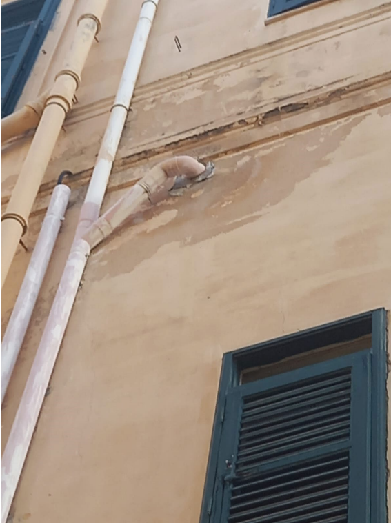
Dettaglio Prospetto "E" Colonne di scarico e pluviali -Evidenti segnali di umidità dovuta ai pluviali
