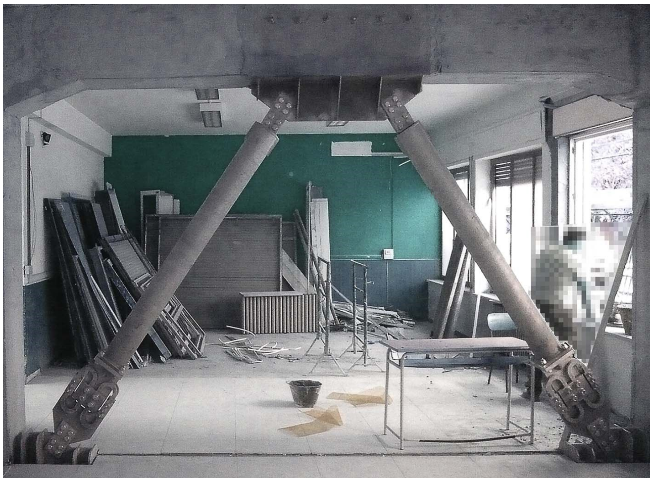
Installazione di controventi dissipativi
