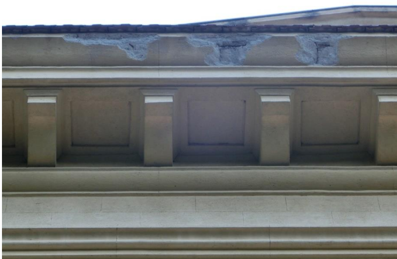
Dettaglio degrado cornicione di coronamento con:
