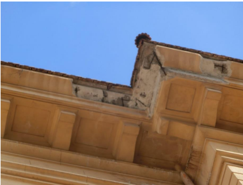
Dettaglio degrado cornicione di coronamento con:
