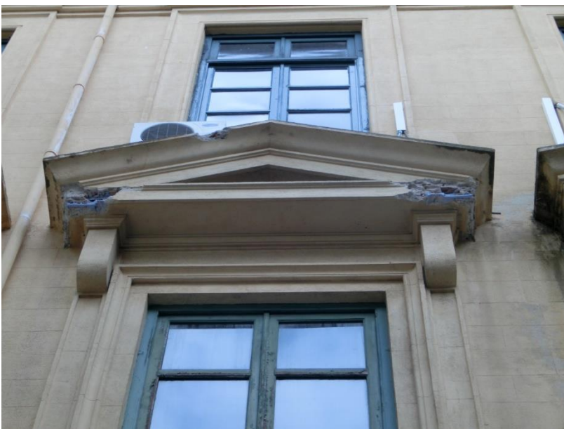
Dettaglio degrado timpano con:
