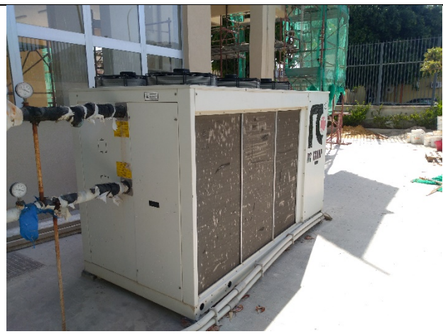
Particolare PDC a servizio dell'UTA piano sec
