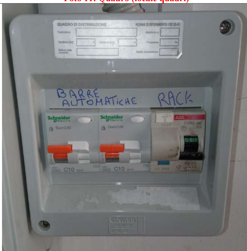
Foto 12: Quadro alimentazione barre automatiche + rack dati (locale quadri)
