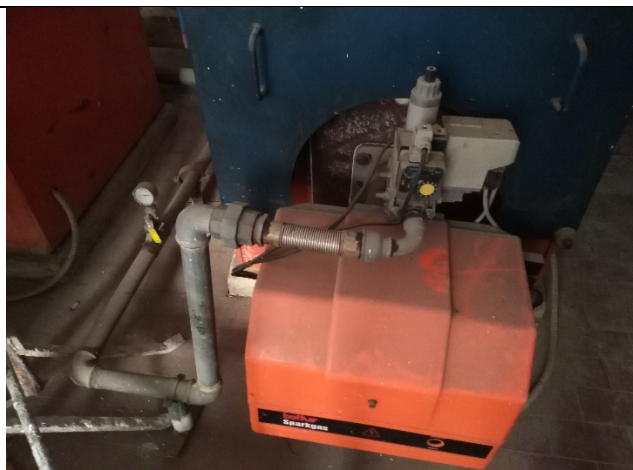
Particolare bruciatore a gas
