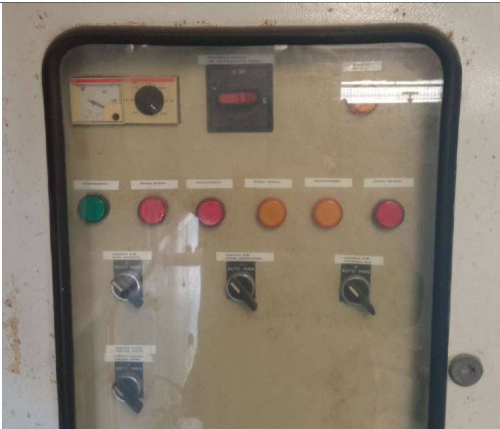
Foto 29 Quadro condizionamento centralizzato (Locale macchine condizionamento)
