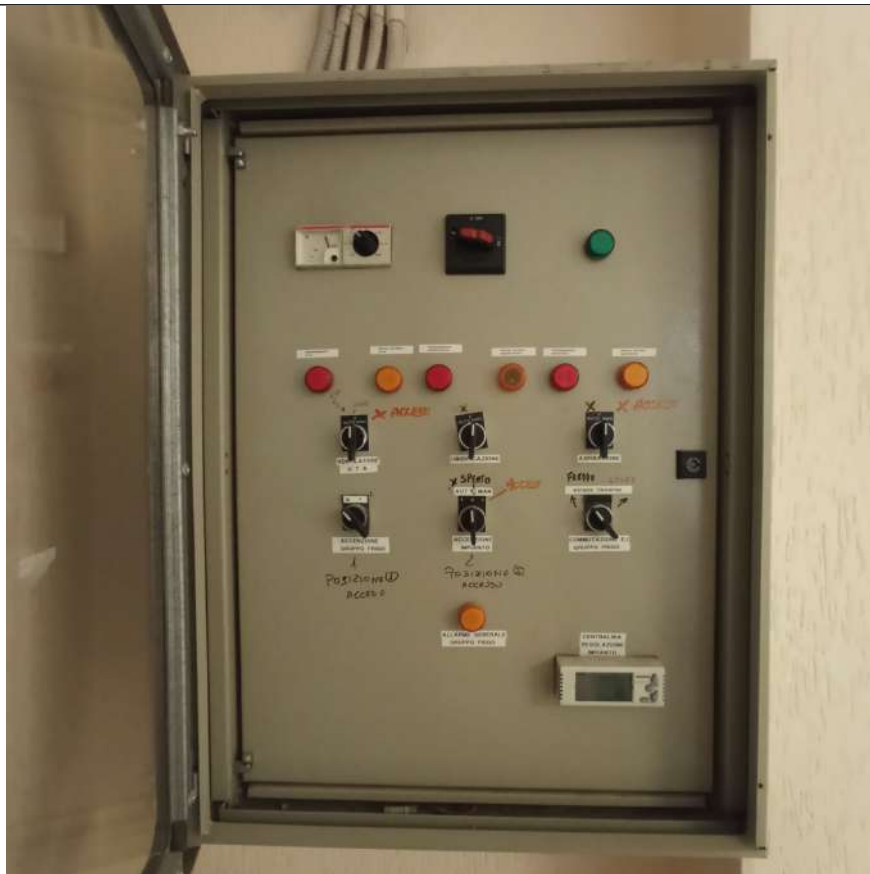
Foto 7: Quadro comandi condizionamento centralizzato (corridoio laterale)
