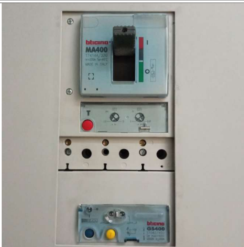
Foto 15: Ingrandimento interruttore magnetotermico + modulo differenziale
