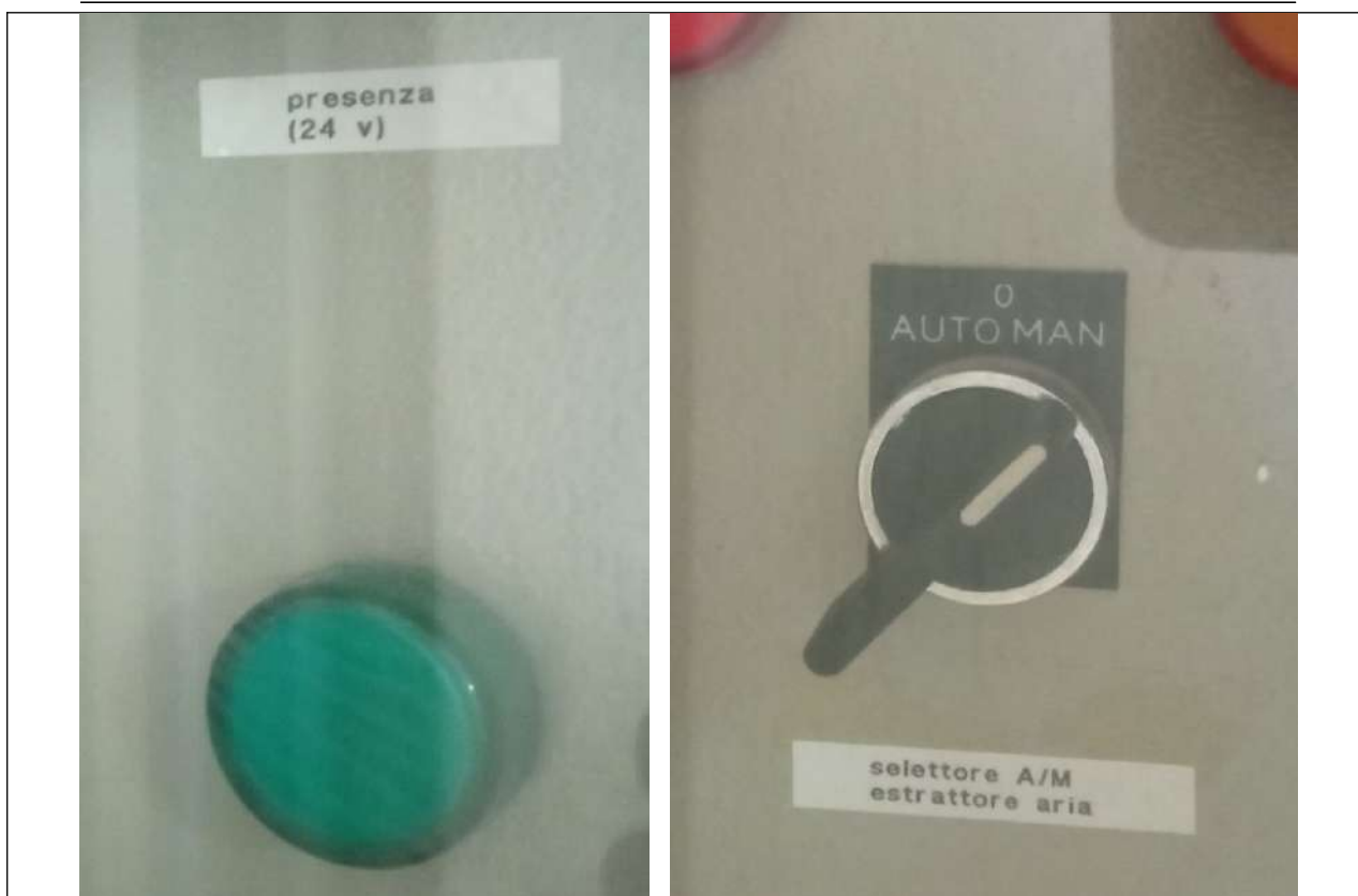
Foto 11: Ingrandimento quadro comandi condizionamento centralizzato
