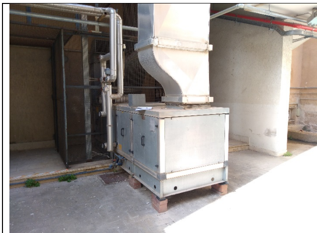
Particolare UTA a servizio dell'aula D piano terra
