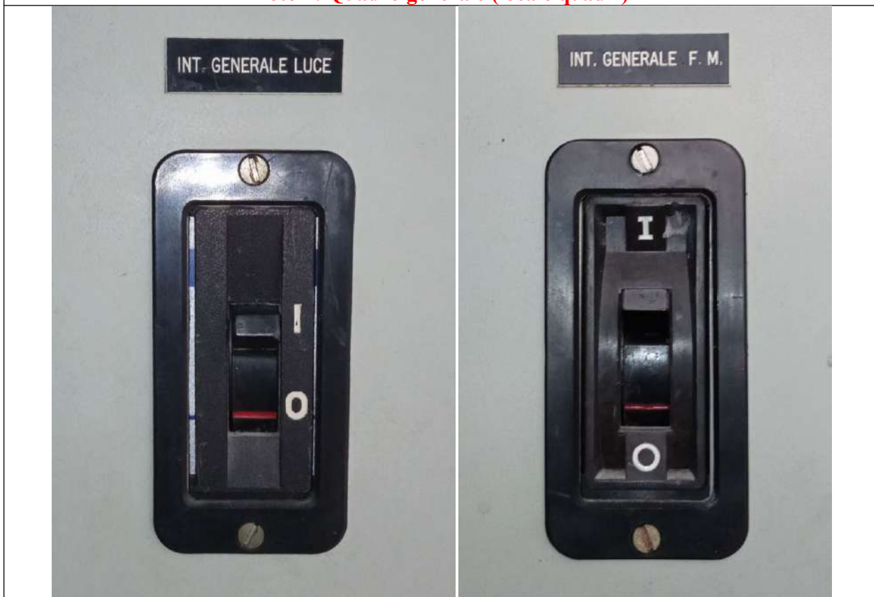
Foto 2: Ingrandimento interruttori generali del quadro generale
