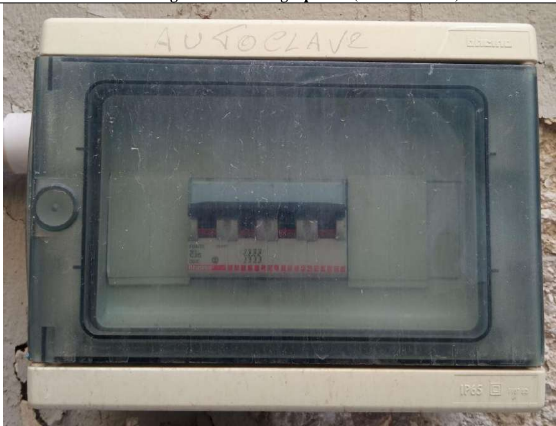
Foto 6: Quadro autoclave (piano cantinato)
