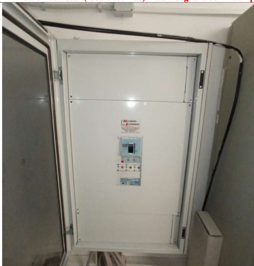
Foto 14: Interruttore magnetotermico + modulo differenziale (locale quadri)
