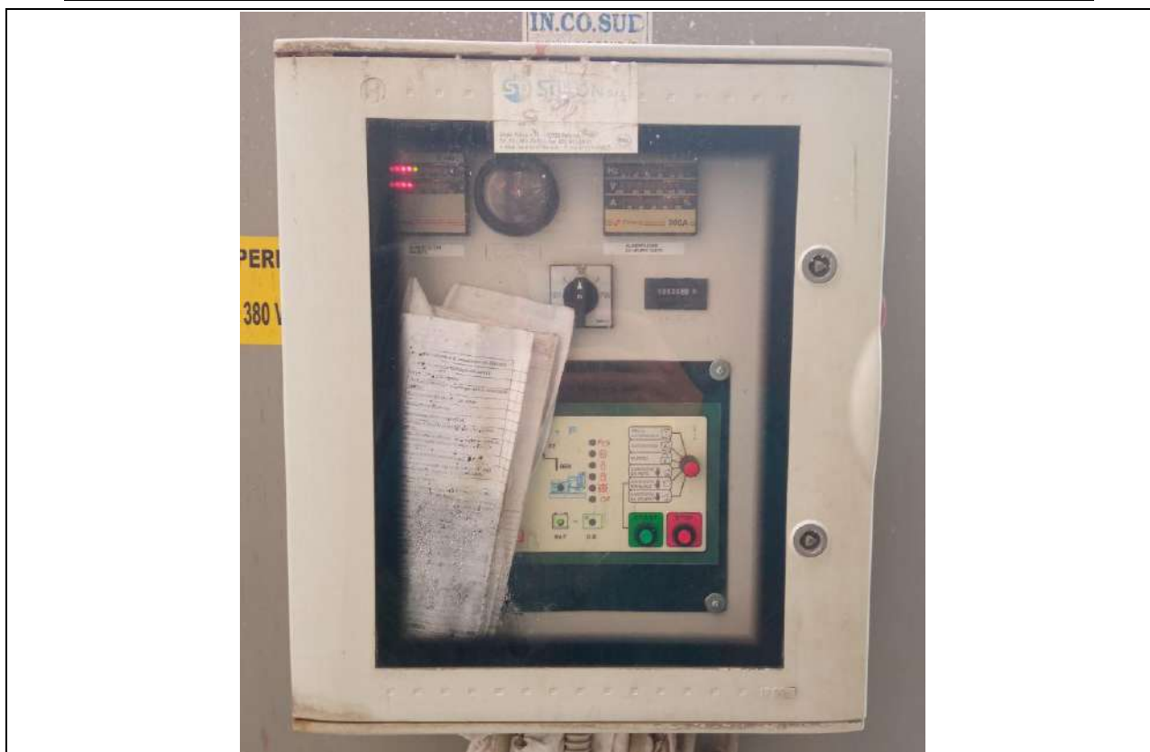
Foto 11: Quadro gruppo elettrogeno (piano terra)
