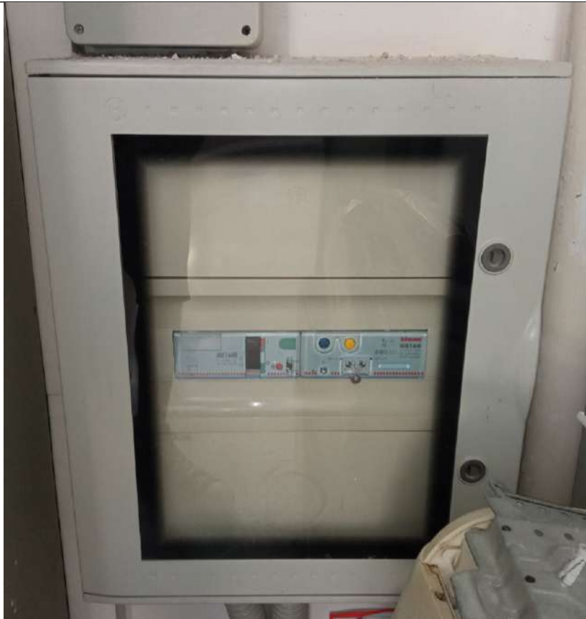
Foto 7: Interruttore magnetotermico + modulo differenziale (locale quadri)
