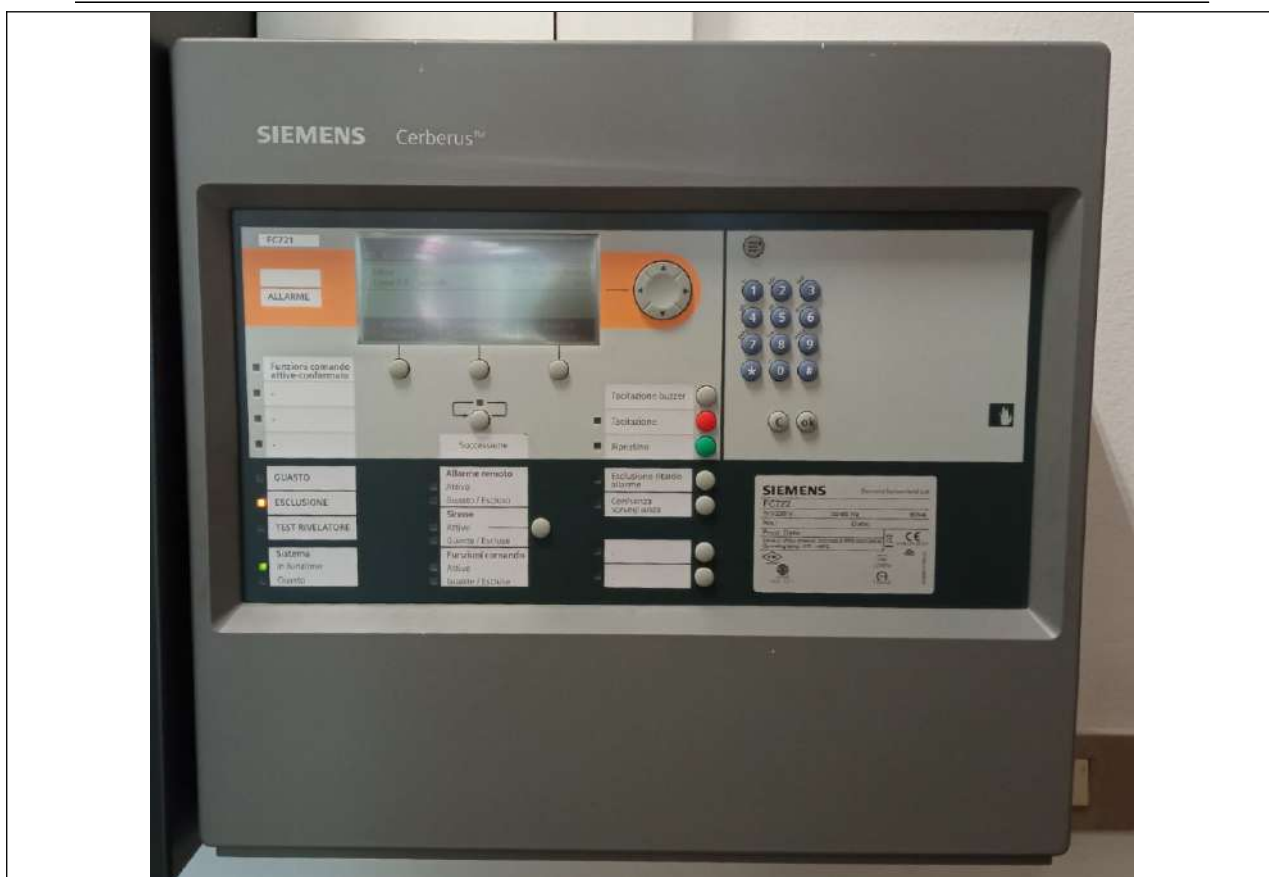
Foto 17: Centrale rivelazione incendio (portineria)
