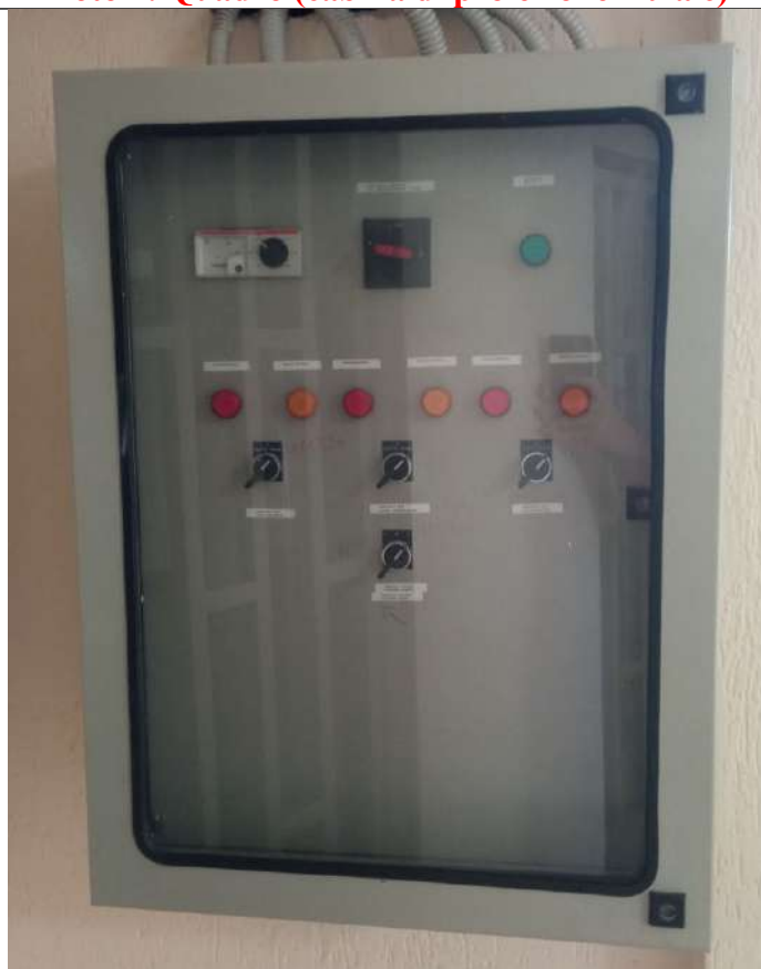
Foto 8: Quadro comandi condizionamento centralizzato (corridoio uff.direttore)
