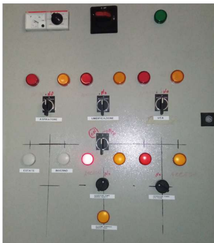
Foto 8: Quadro comandi condizionamento centralizzato (corridoio lato Aula I)
