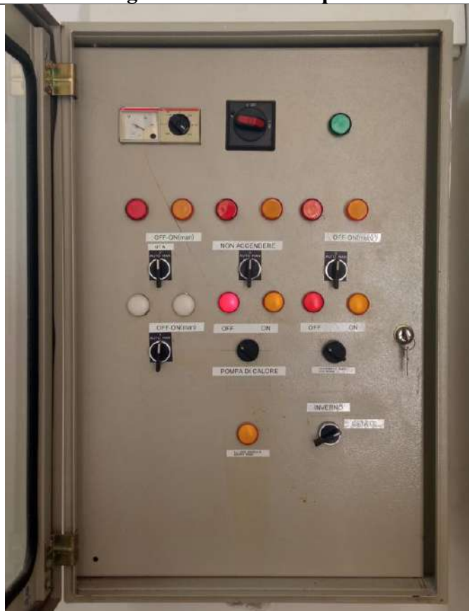
Foto 26: Quadro comandi condizionamento centralizzato (corridoio B)
