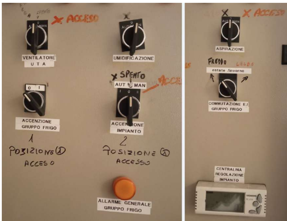
Foto 9: Ingrandimento quadro comandi condizionamento centralizzato
