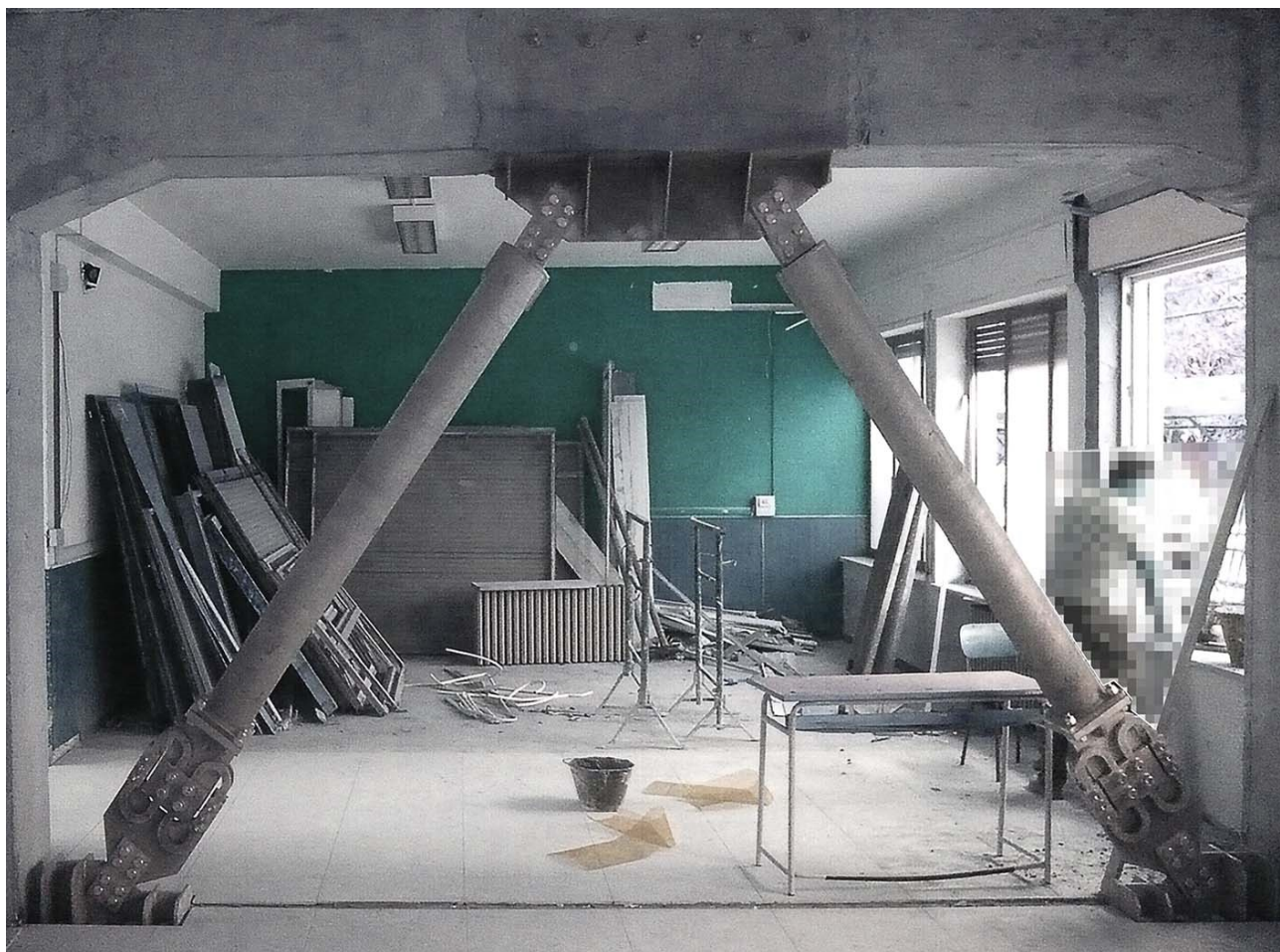
Installazione di controventi dissipativi
